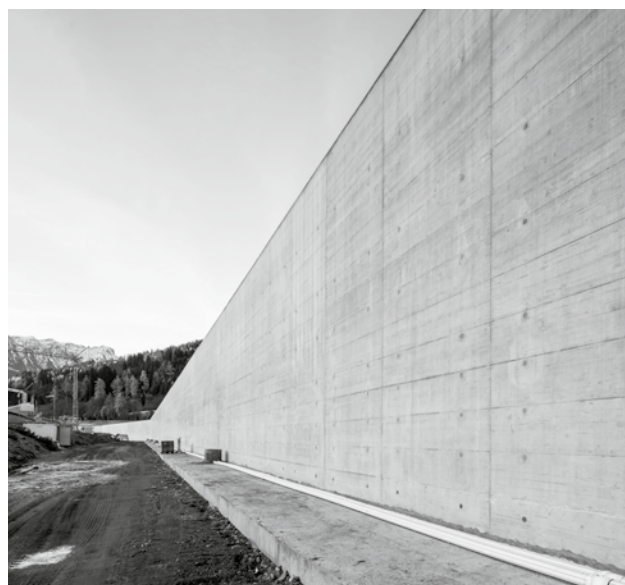
Umfassungsmauer JVA Realta
